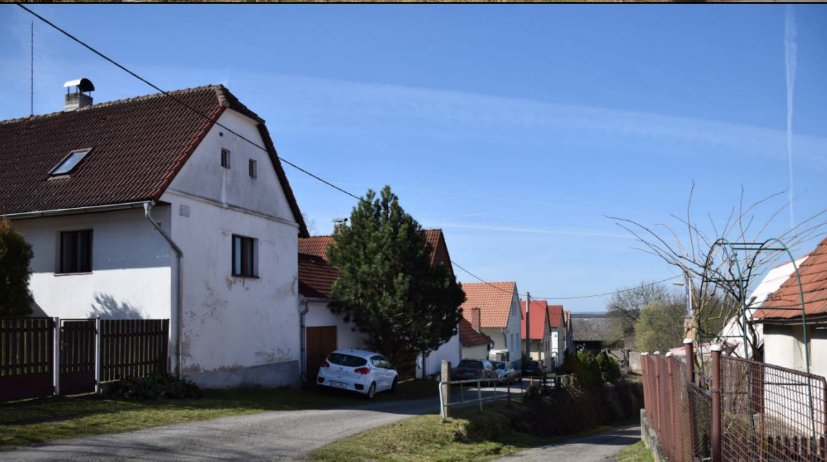
mladší plánovitě vzniklá zástavba
