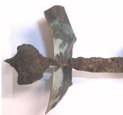
Urychlení koroze železného šroubu v místě průchodu měděným pláštěm sochy Jiřího z Poděbrad
