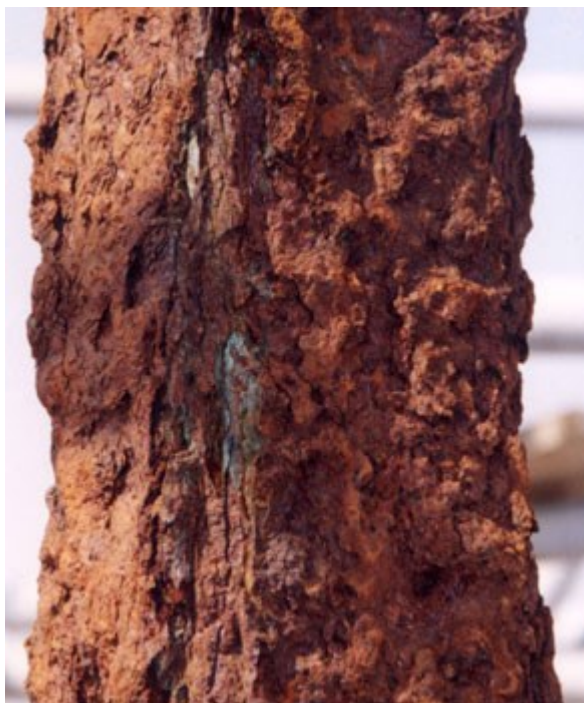
Koroze hlavního nosníku sousoší Nejsvětější Trojice v Olomouci
