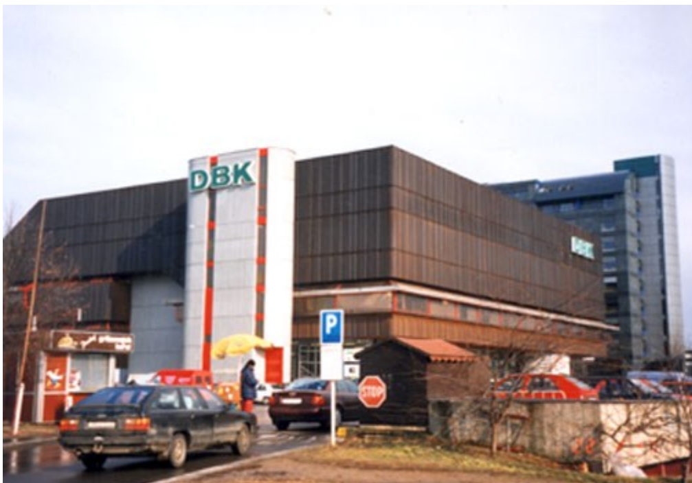
Fasáda obchodního domu zhotovená z patinující oceli Atmofix
