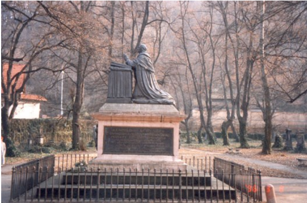
Litínový náhrobek biskupa Leopolda Thun-Hohensteina na Malostranském hřbitově v Praze opatřený grafitovým nátěrem
