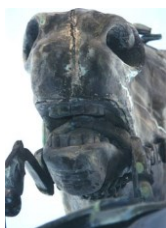
Roztržený měděný plášť na soše Jiřího z Poděbrad v důsledku koroze železné nosné kostry
