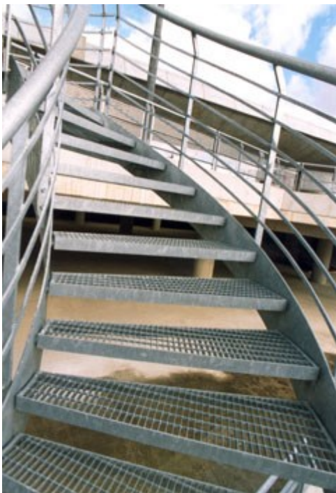
Žárově zinkovaná ocelová konstrukce vnějšího schodiště (převzato
