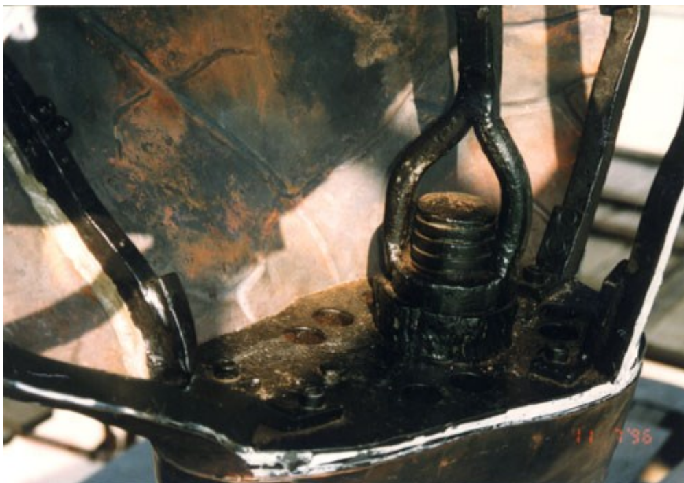
Protikoroziční opatření na soše Jiřího z Poděbrad (drenážní otvory, nátěrový systém oceli, izolační páska)
