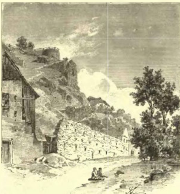
Staré hradby u Lužnice a bašty na Táboře
