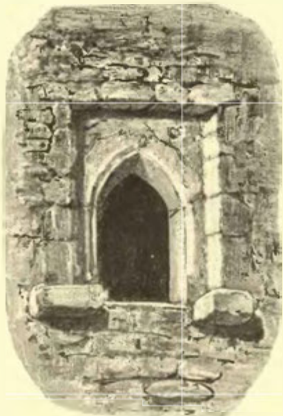
Dvěře na hlásce Selmberské.
