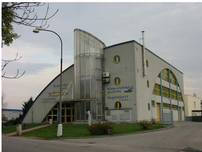
Obrázek 6.4: Administrativní budova v Českých Budějovicích
