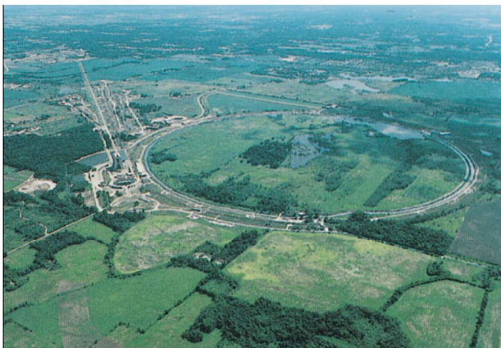
Obr. 29.16 Letecký pohled na Fermilab
