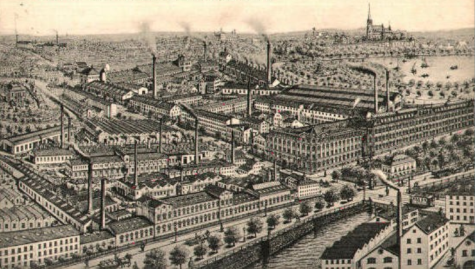
Chemnitz. Sächsische Maschinenfabrik vorm. Rich. Hartmann.
